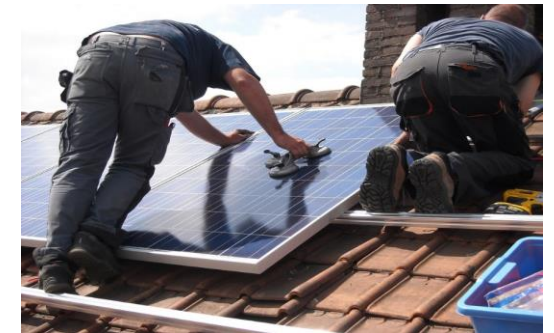
INSTALACIÓN y OBRAS ELECTROMECÁNICAS
